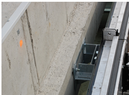
Přípevnění přesazené fasády z boku stropní desky
