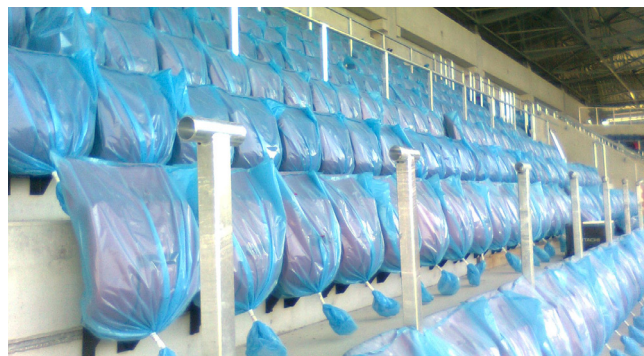
Stadion Trnava - přichycení sedaček do kolejnic TA 38/17 pomocí šroubů 38/17
