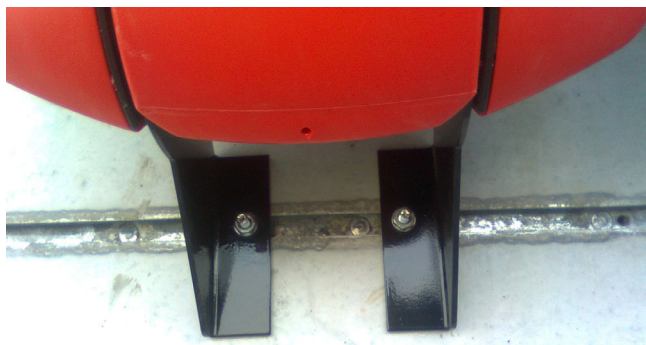
Stadion Trnava - přichycení sedaček do kolejnic TA 38/17 pomocí šroubů 38/17
