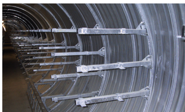
Přípevnění kolektorového vedení
